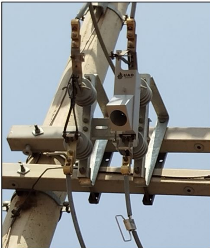
Figura 10. Dispositivo de bloqueio na posição fechada
