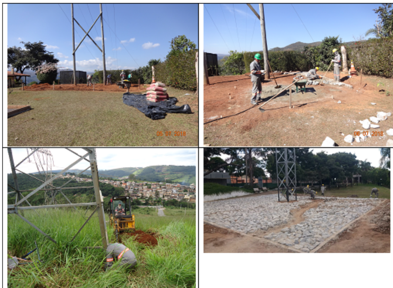
Figura 3 – Execução de cobertura de solo com pedras
