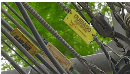
Figura 6 - Visualização detalhada de etiquetas de identificação em postes para uso compartilhado.
