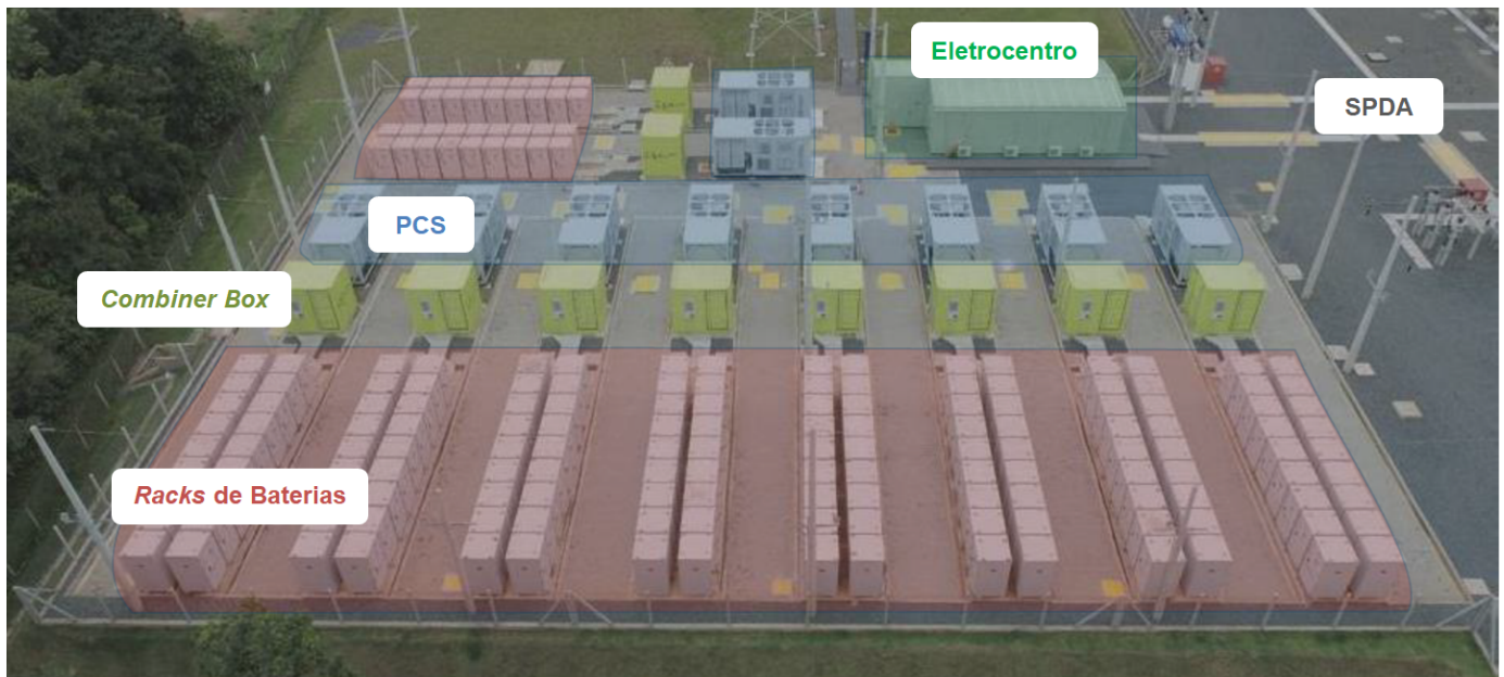
Figura 1. Visão geral do BESS da ISA Energia Brasil localizado em Registro-SP. Elaboração Própria.
