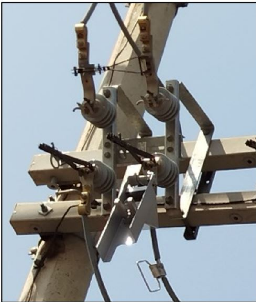
Figura 9. Dispositivo de bloqueio na posição aberta
